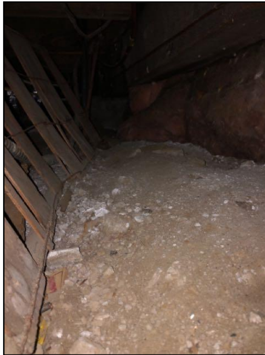
No vapor barrier
